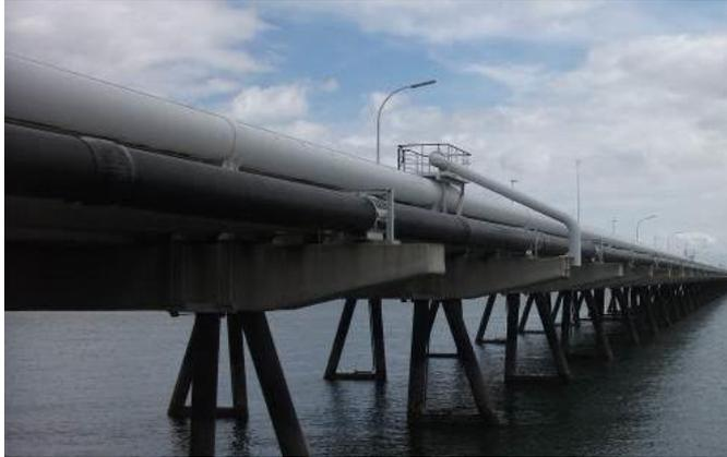
Die Pfeiler einer Brücke sind mit asbest- und PAK haltiger Korrosionsschutzbeschichtung beschichtet, nach mehr als dreißig Jahren muss sie erneuert werden.
